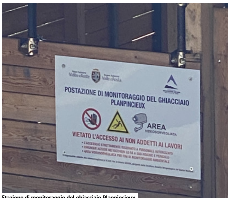
Stazione di monitoraggio del ghiacciaio Planpincieux
