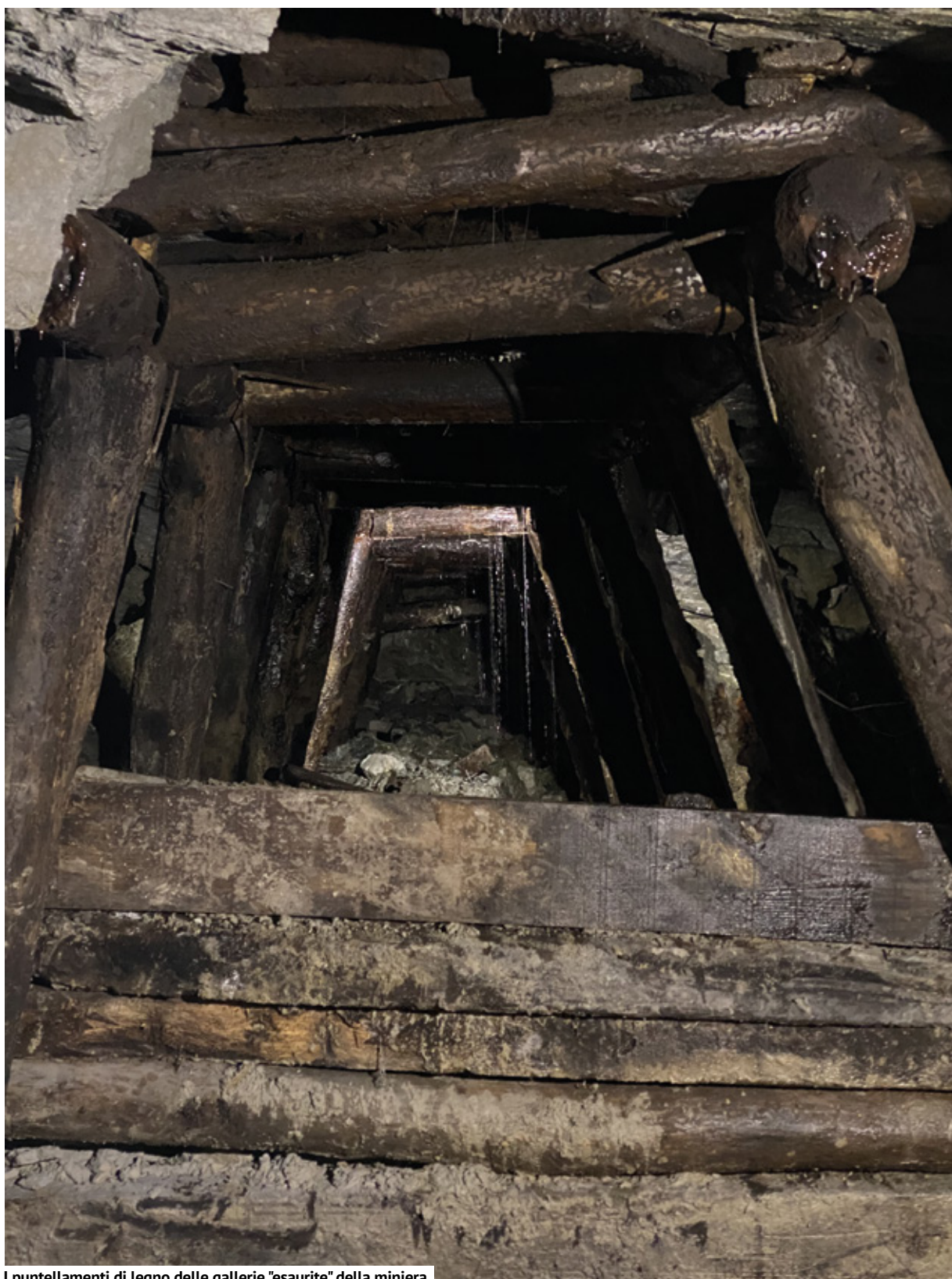
I puntellamenti di legno delle gallerie "esaurite" della miniera
